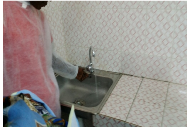
Reprise de la Paillasse et nouvel évier inox
